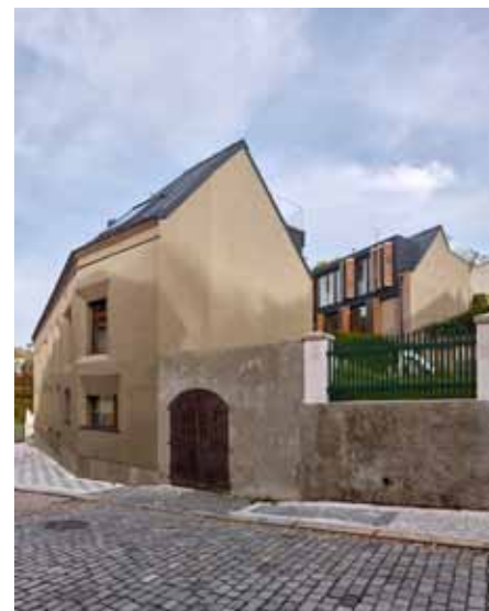
Trojkrídlý půdorys stavby obemýká dvůr – řešení vycházelo ze snahy respektovat kontext místa, ale zároveň sem vnést nové tvarové a materiálové elementy
