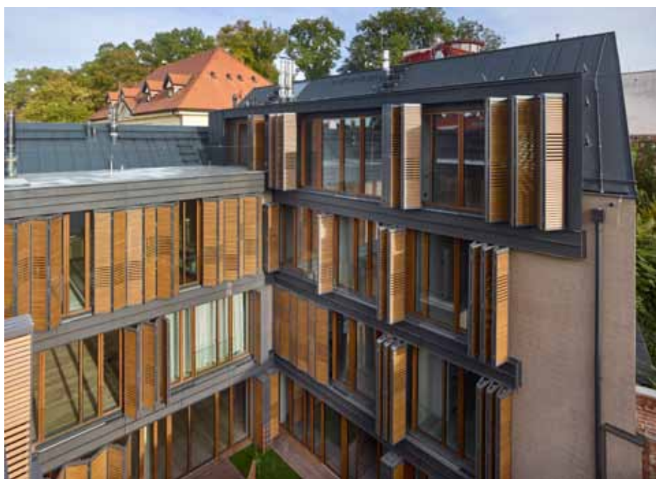
Bytový dům zachoval objemovou a půdorysnou stopu předchozích staveb: má tři nadzemní podlaží a sedlovou střechu
